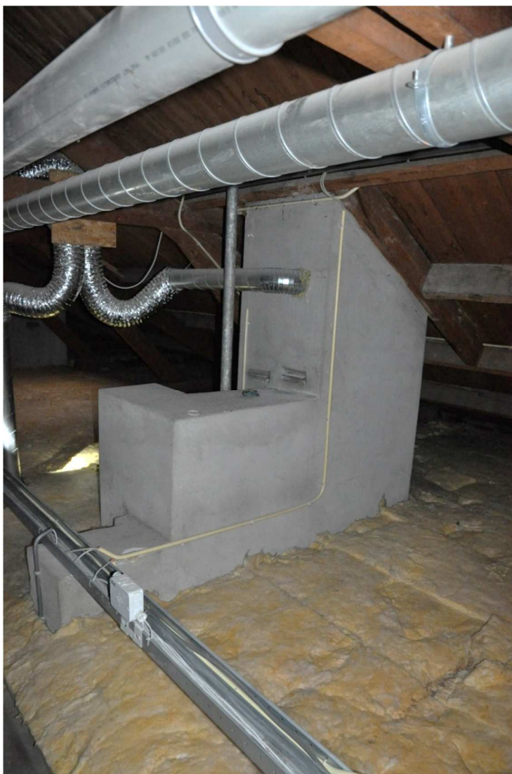
163 Oude ventilatieschacht met later aangebrachte metalen ventilatiekanalen.
