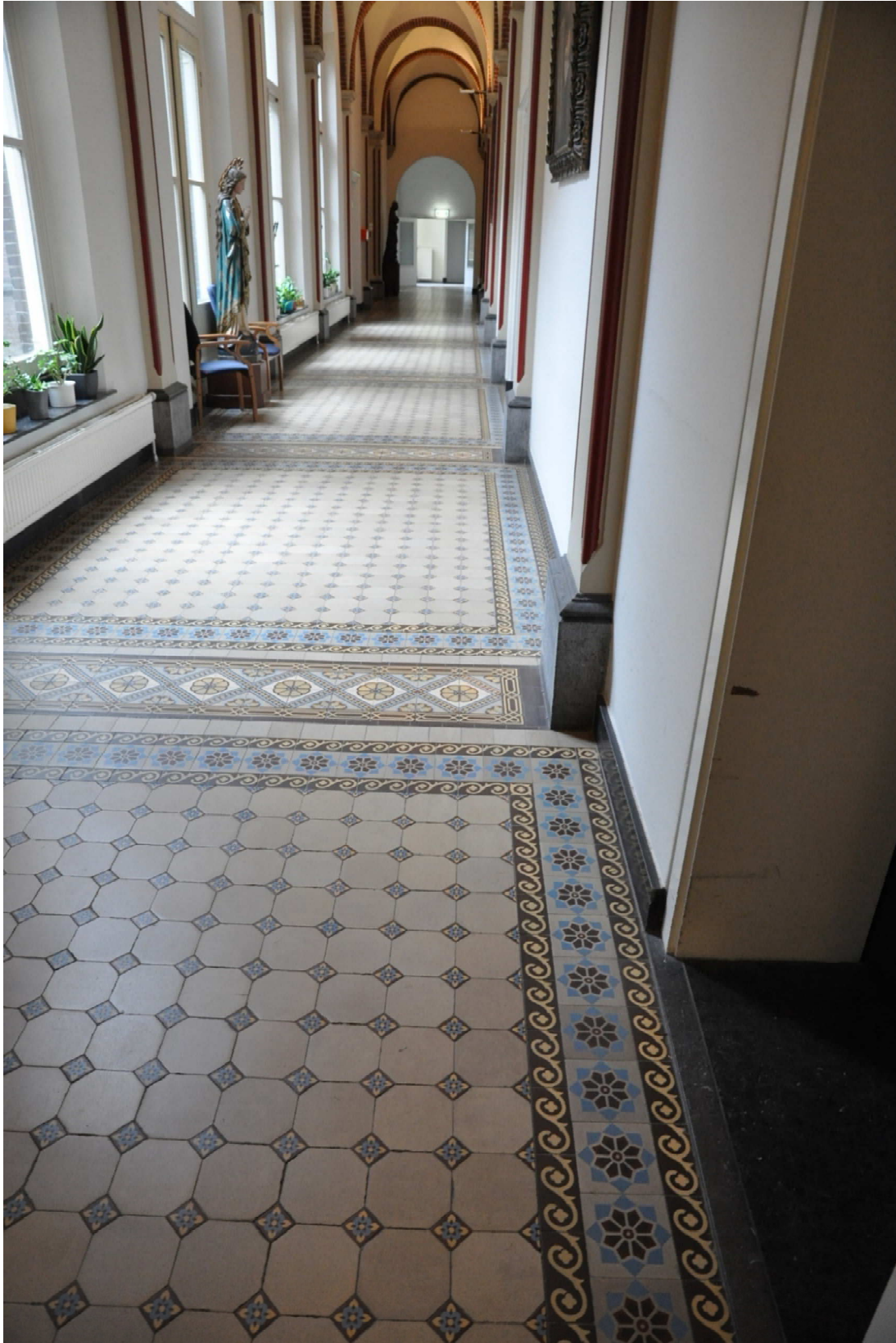
87 Detail van de vloer- en wandafwerkingen in de gang van de middenvleugel, gezien richting het zuiden.
