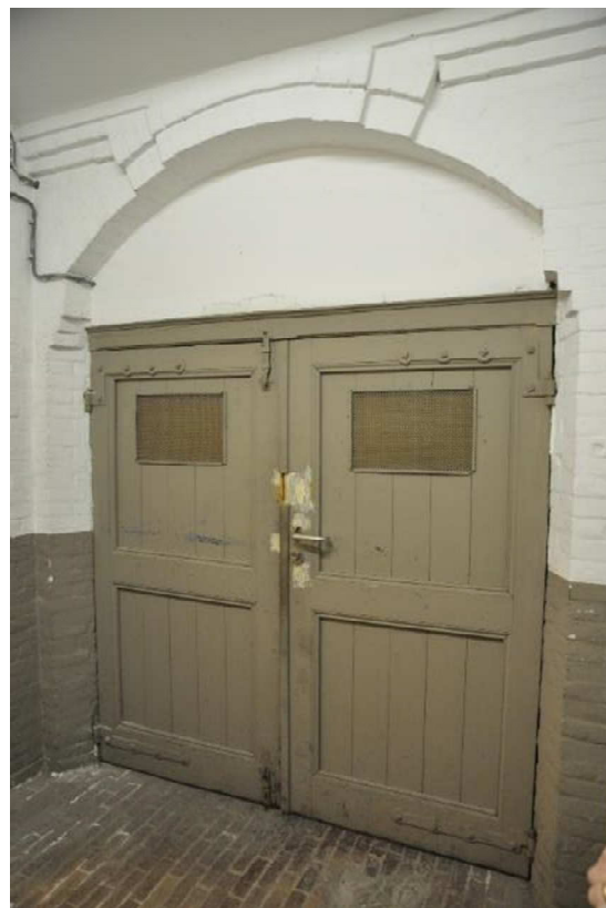
74 Eén van de dubbele opgeklampte deuren uit 1894.
