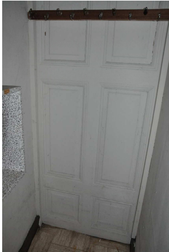
125 Oorspronkelijke paneeldeur van de berging.
