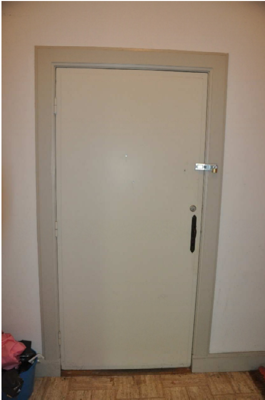
124 Eén van de vernieuwde binnendeuren.
